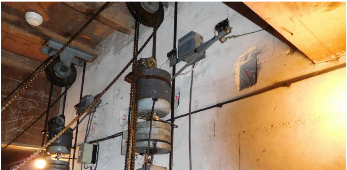
4 encastremets d'anciennes poutres et rehaussement du plafond pour pouvoir y mettre le cadran de l'horloge.
