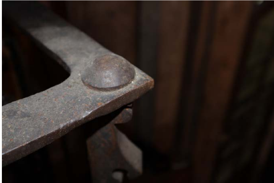
Rivetage des colonnes
