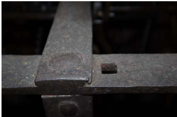
clavetage d'une barre horizontale
